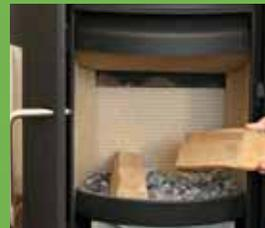
2-3 cm Asche sind eine gute Unterlage für das Feuer. Legen Sie zuerst ein paar Stücke Holzscheite (ca. 1/2 kg) auf den Boden der Brennkammer.
